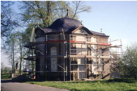
Mit Renovierungen kennt sich das Barockgebäude aus. Bereits 1980 rückten der Kapelle verschiedene Gewerke zu Leibe, um kleinere und größere Reparaturen auszuführen.
