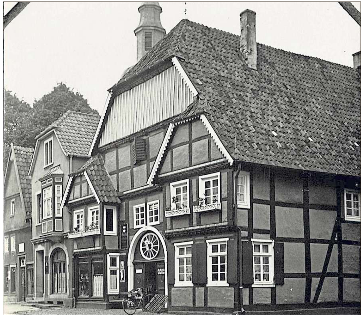
Eine wechselvolle Geschichte hat das an Haus der Rathausstraße 35 in Rietberg erlebt. Die Aufnahme des Gebäudes stammt aus dem Jahr 1920. Fotos: privat
