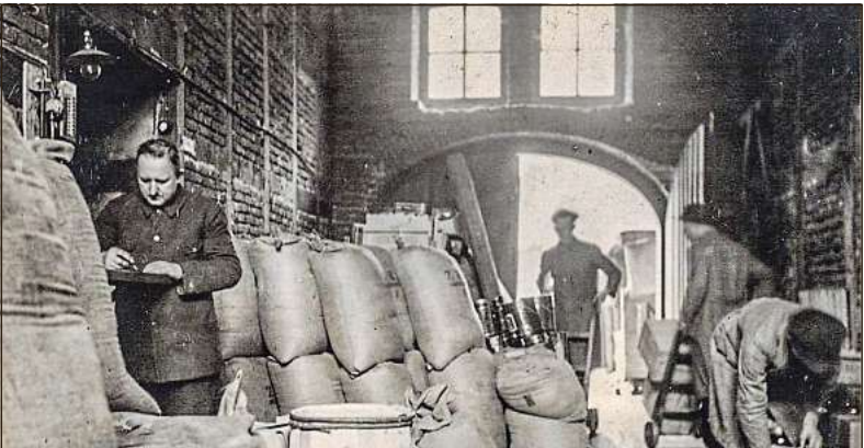
So sah es früher im Lagerraum des Hauses im Erdgeschoss aus. Im ersten Stock waren Büroräume untergebracht.
